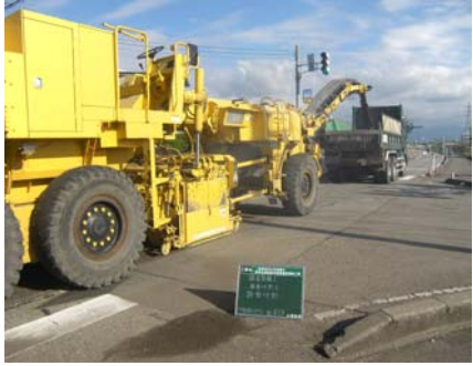
路面切削状況
