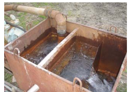
ウエルポンプからの排水状況
