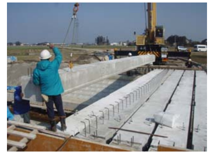
上部工桁架設状況（右岸側より）
