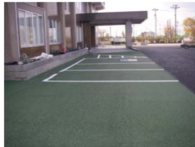
工事完成後①
