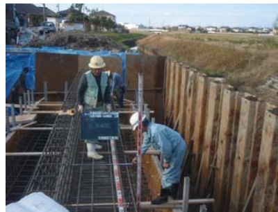
同 橋台鉄筋組立工確認
