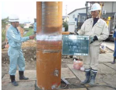
センター監督員による鋼管杭溶接部チェック
