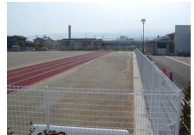
グラウンド舗装工事 完成
