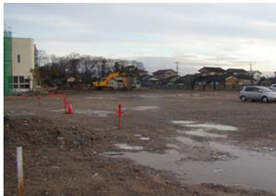
グラウンド舗装工事 着手前
