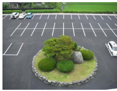
工事完成後②
