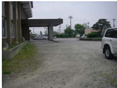
工事着工前①
