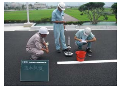
センター監督員による現場透水試験
