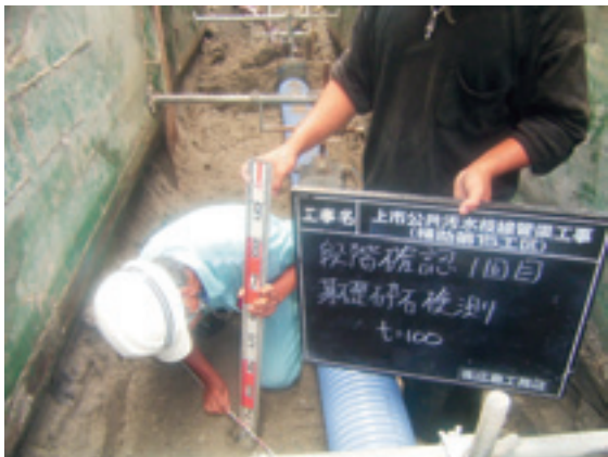
管基礎厚さ確認
