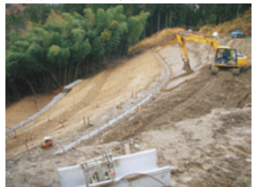
復旧作業(法尻には、かご多段積み)
